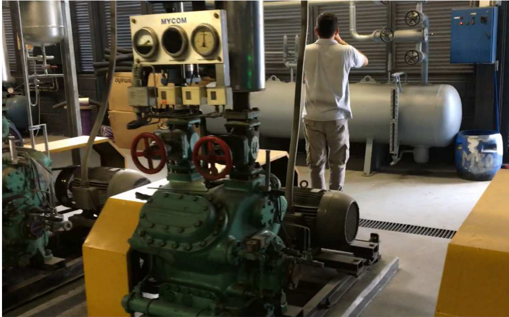
Fig 3 Bomba (primer plano) y Separador de Alta (fondo).
