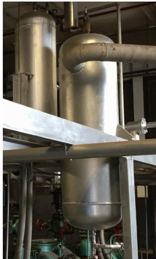
Fig 4 Separador de Alta con recubrimiento y separadores de aceite.
